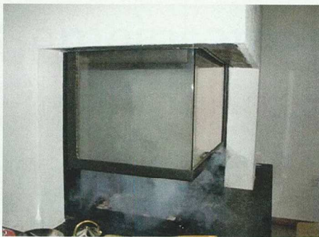
Bei einem Druckunterschied von mehr als 4 Pa besteht die Gefahr, dass die Abgase der Feuerstätte nicht mehr sicher über die Abgasanlage ins Freie abgeführt werden, sondern in den Aufstellraum austreten. Bilder: Schornsteinfeger-Innung Düsseldorf
