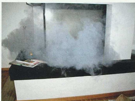
Bei einem Druckunterschied von mehr als 4 Pa besteht die Gefahr, dass die Abgase der Feuerstätte nicht mehr sicher über die Abgasanlage ins Freie abgeführt werden, sondern in den Aufstellraum austreten. Bilder: Schornsteinfeger-Innung Düsseldorf
